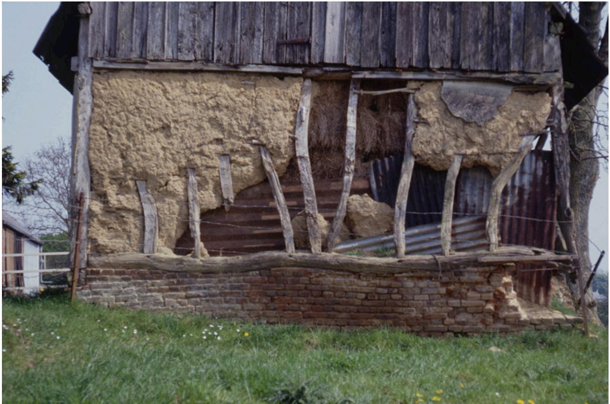
Dorengt, ferme (repérée), ruelle des Près : structure du pignon ouest de la grange en pan de bois et torchis sur solin de brique.
