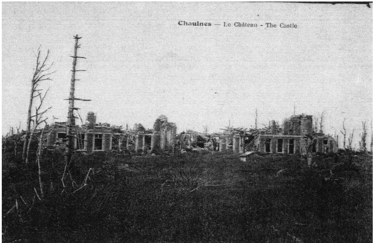
Ruines du bâtiment du grand commun, après 1916 ? (Historial de la Grande Guerre, Péronne ; n° 20993).
