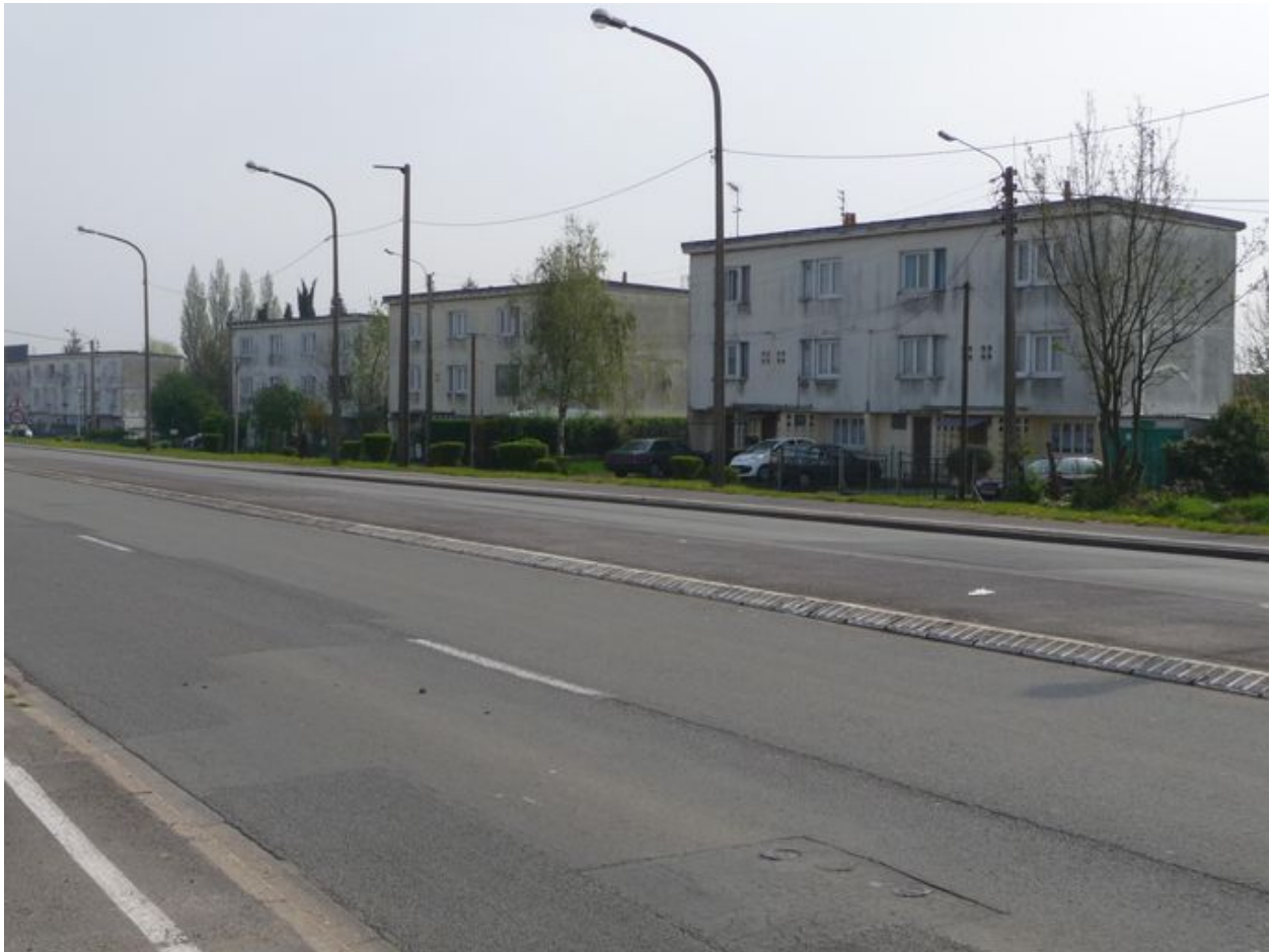
Vue générale de la cité depuis la Route Nationale.
