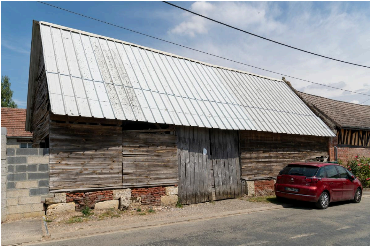
Ancienne grange sur rue avec entrée charretière, n°10 rue d'En Haut, vue depuis le sud-ouest.
