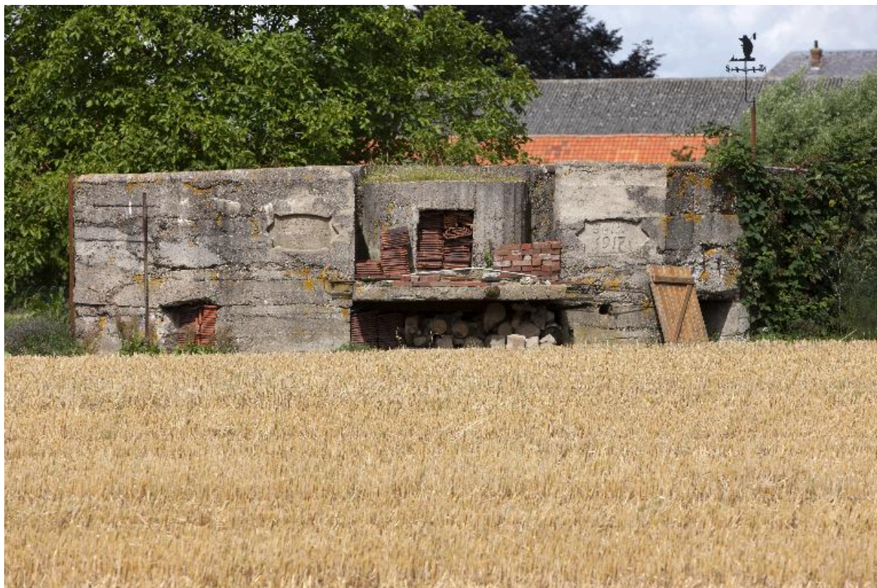
Élévation antérieure vers le nord-ouest
