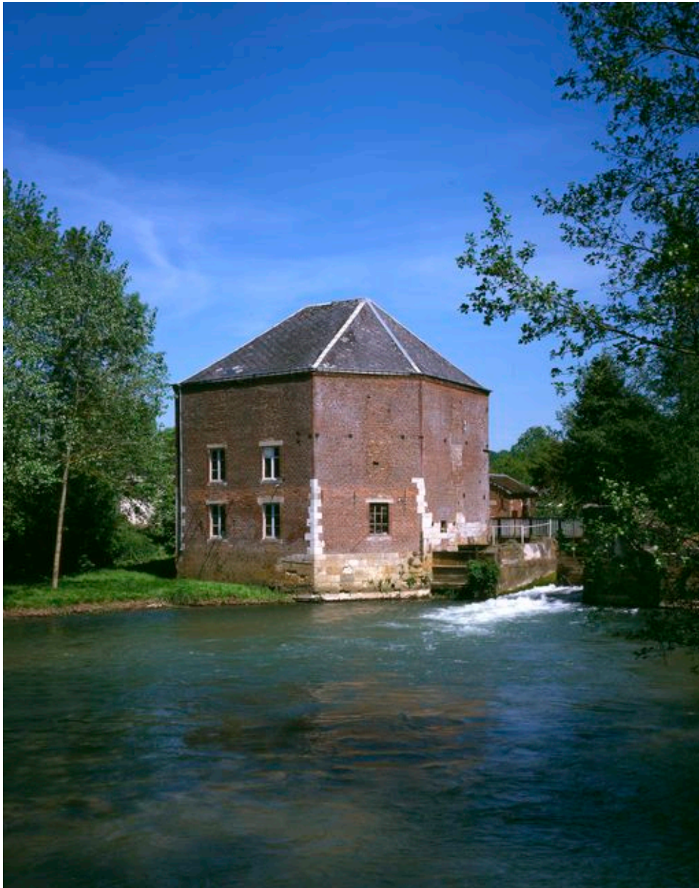
Vue du moulin depuis le sud-ouest.
