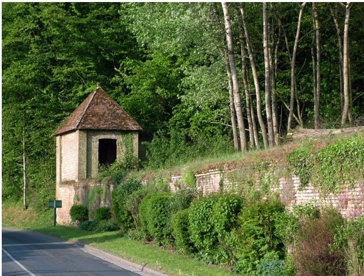
Mur de clôture du parc et pavillon d'angle au sud-ouest.
