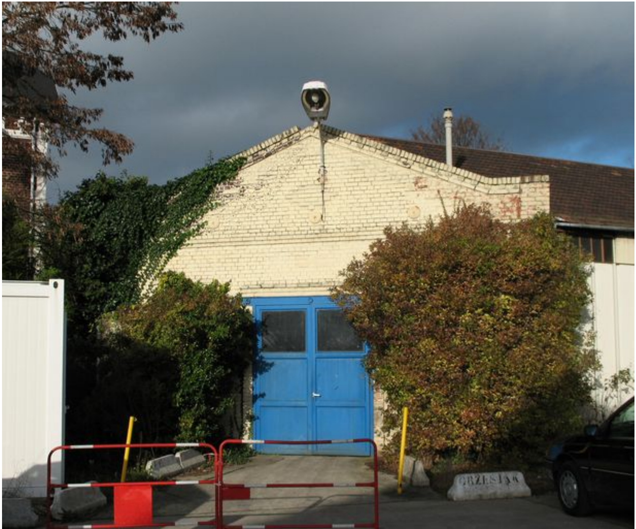
Bâtiment de la maintenance.
