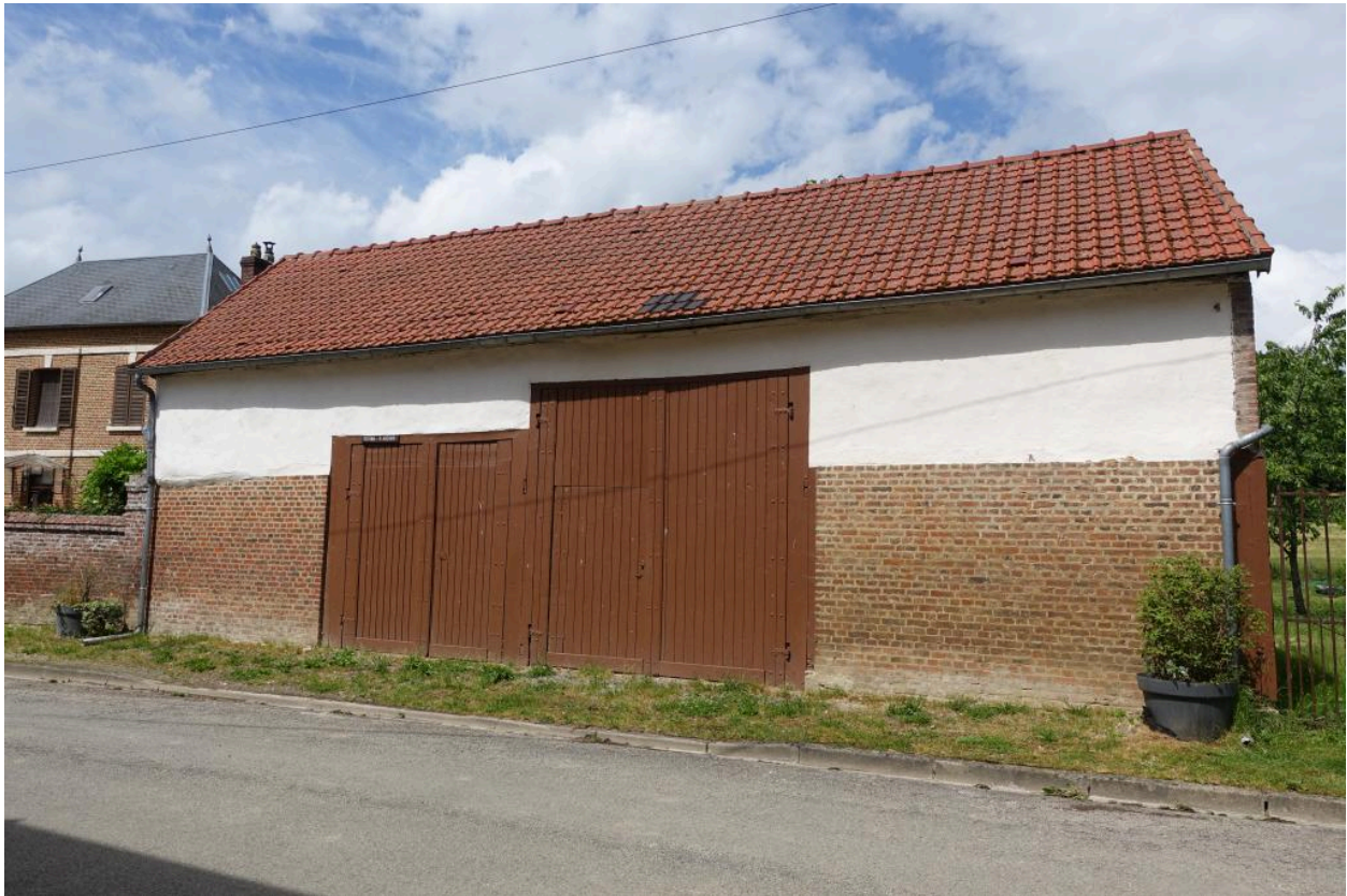
Grange sur rue en face du n°10, vue depuis l'est.
