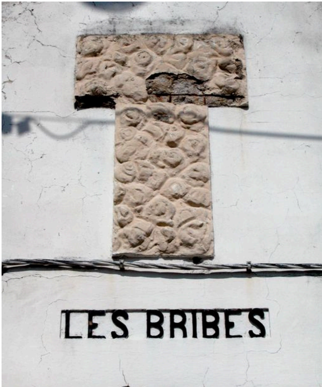
Détail du décor porté sur le fronton en façade (motif de roses).
