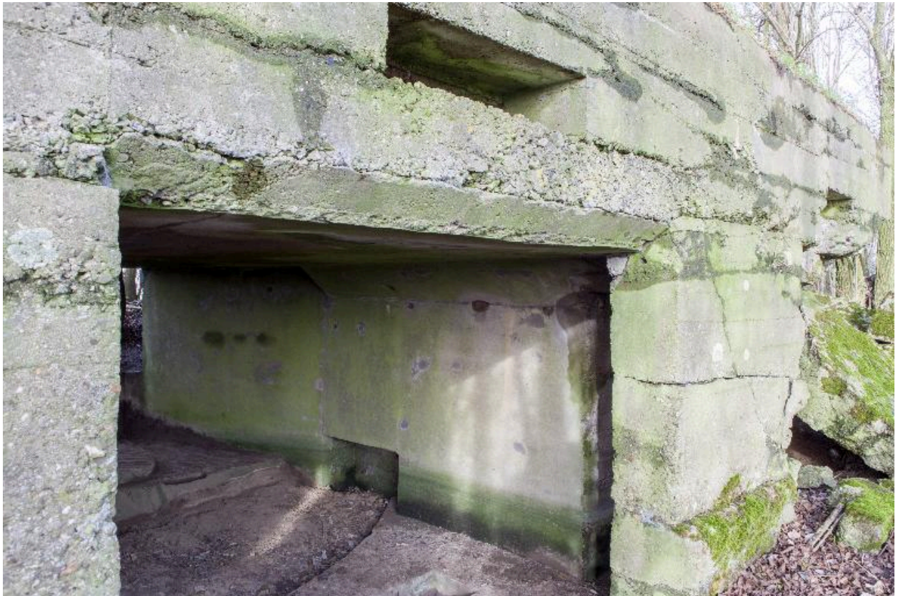
Élévation sud, détail de la cellule d'éclatement
