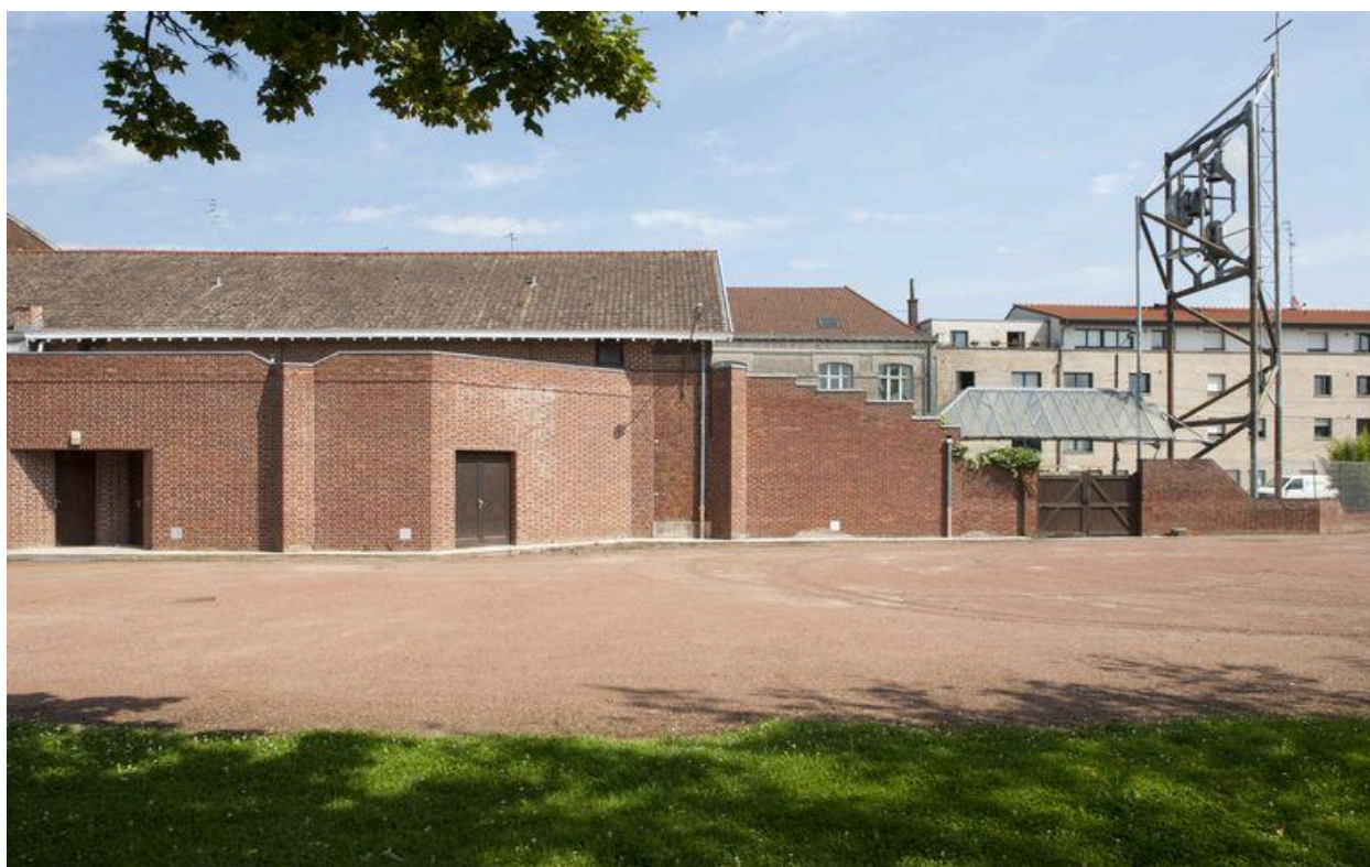
Façade côté sud et clocher.
