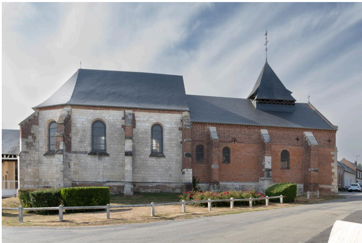
Élévation nord de l'église.
