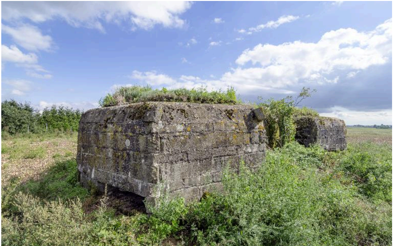
Vue de trois-quarts vers le sud-est
