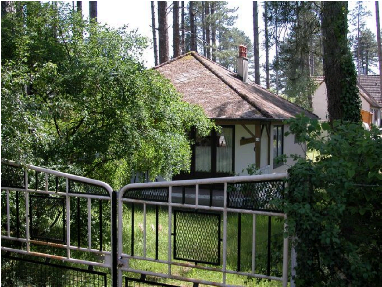
Maison dite Rokérou, 40 avenue des Sapins.
