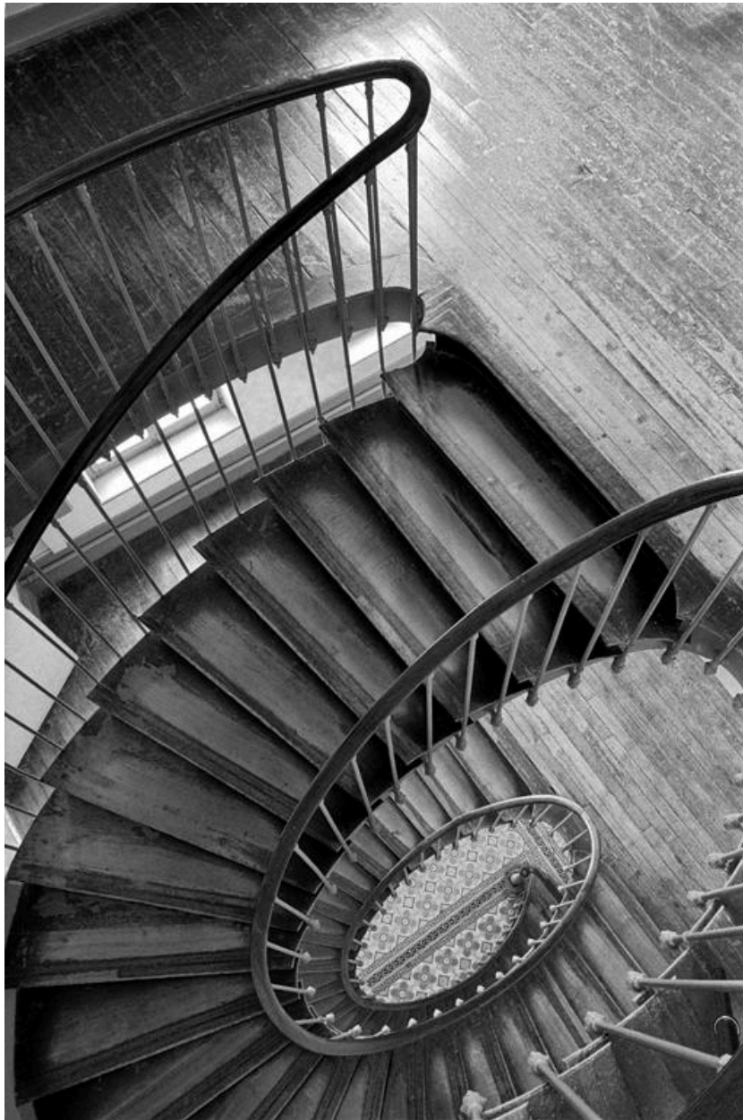
Vue intérieure en plongée de l'escalier suspendu du bâtiment principal.
