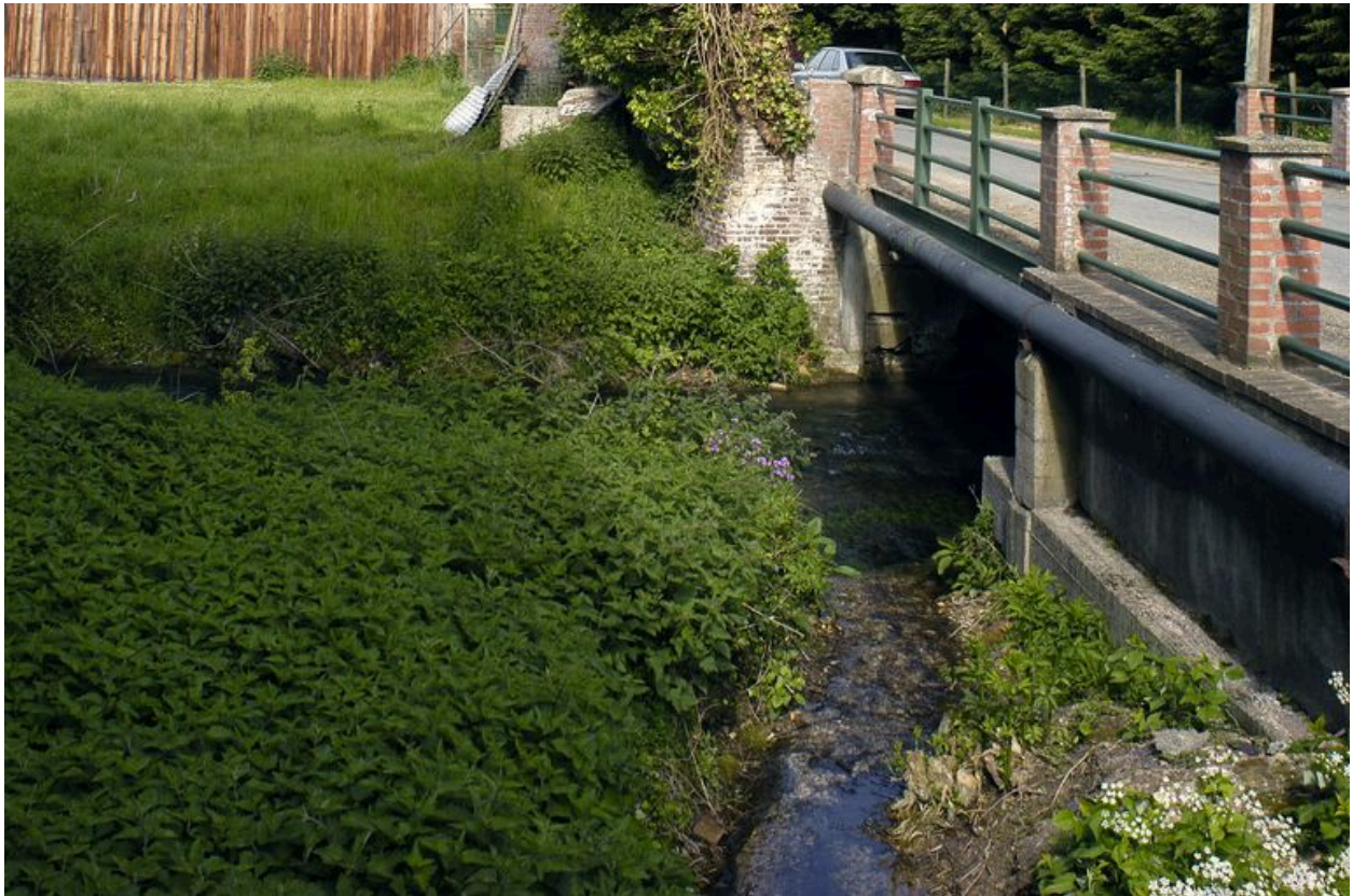
Le canal de fuite.
