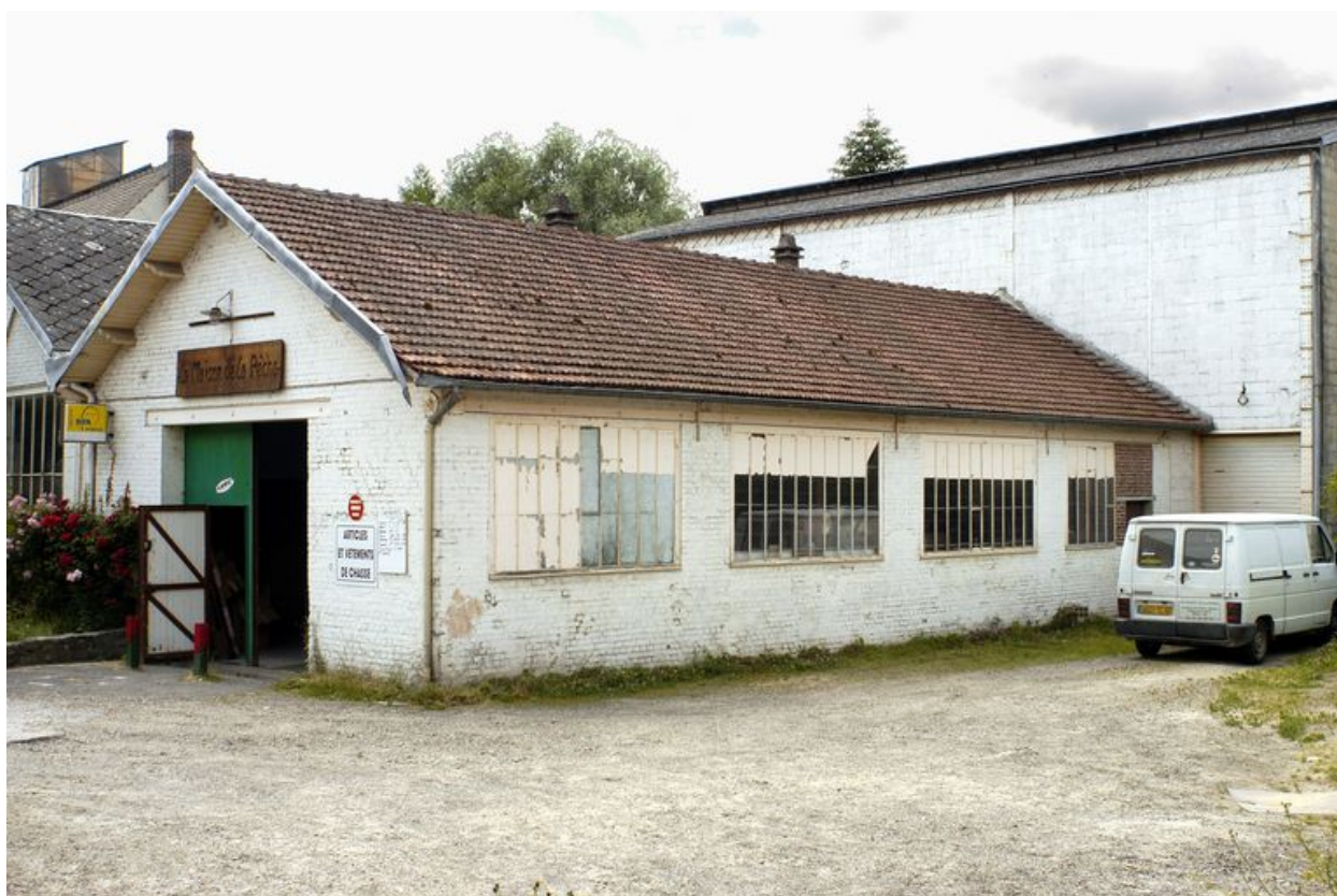
Vue d'un des atelier de fabrication.
