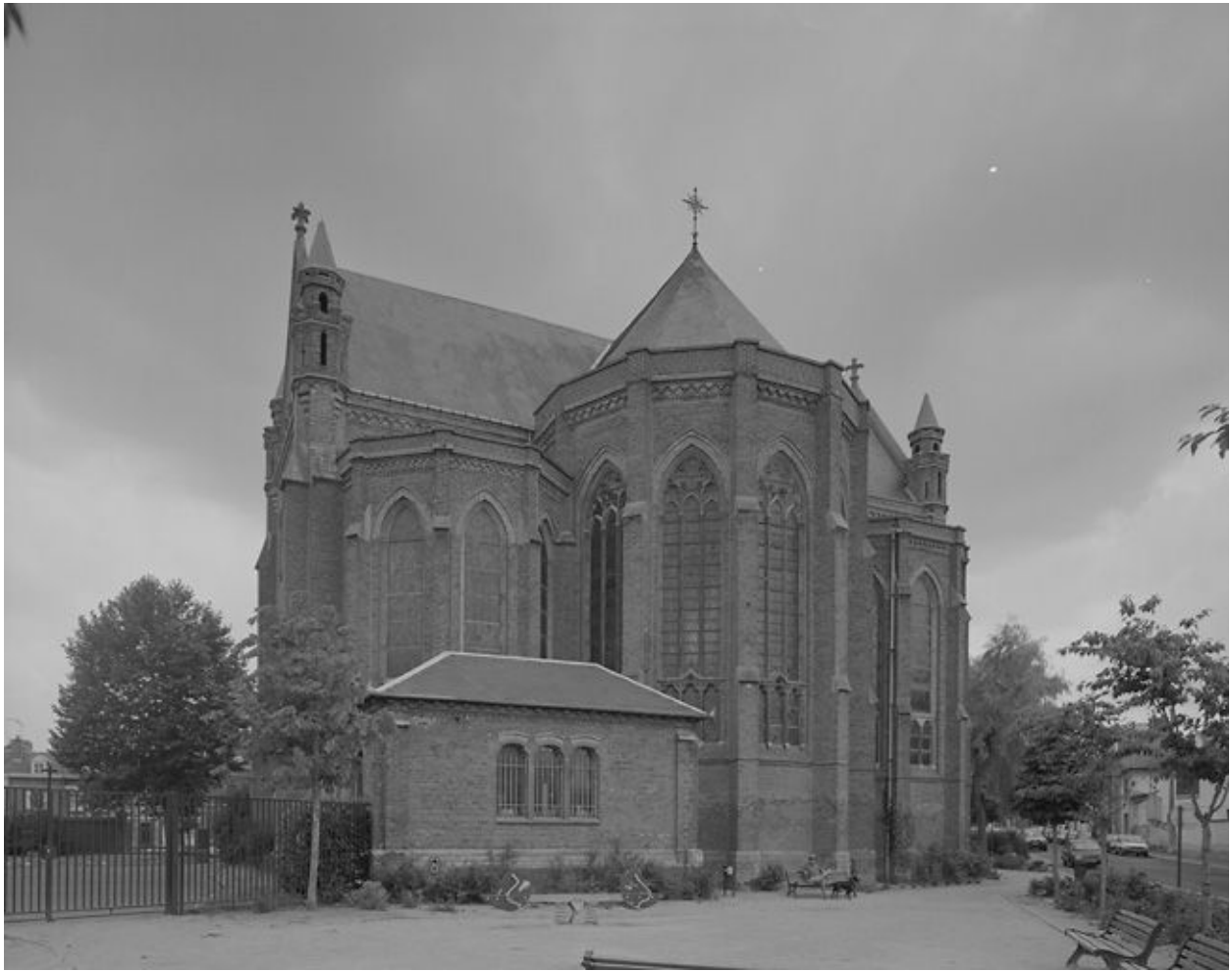
Vue générale depuis le nord-ouest.
