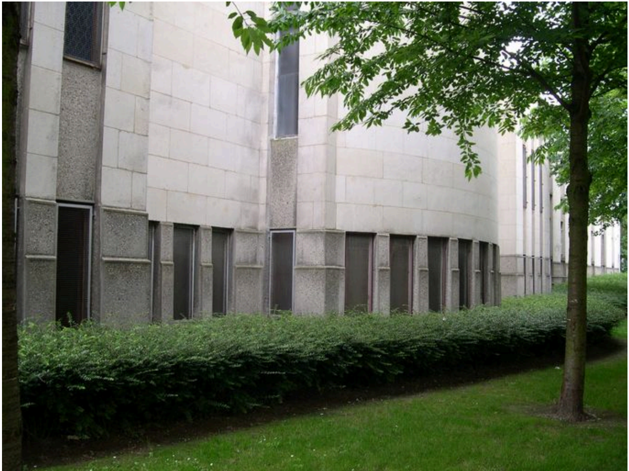
Vue de détail : base de la façade est.
