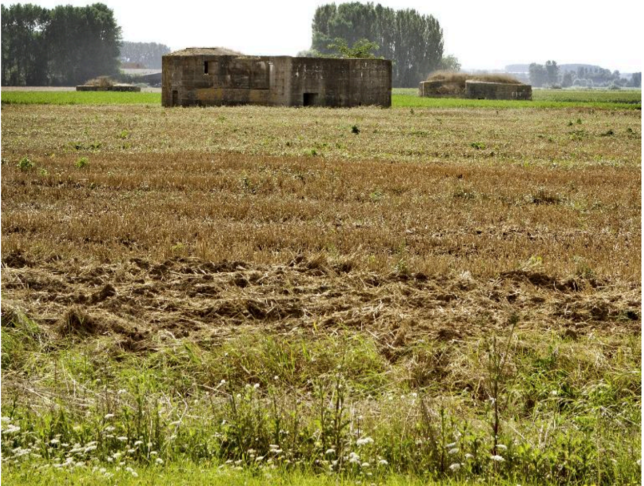
Vue générale vers sud ouest. En arrière plan, deux autres casemates à mitrailleuse (IA59004921 et IA59004903)
