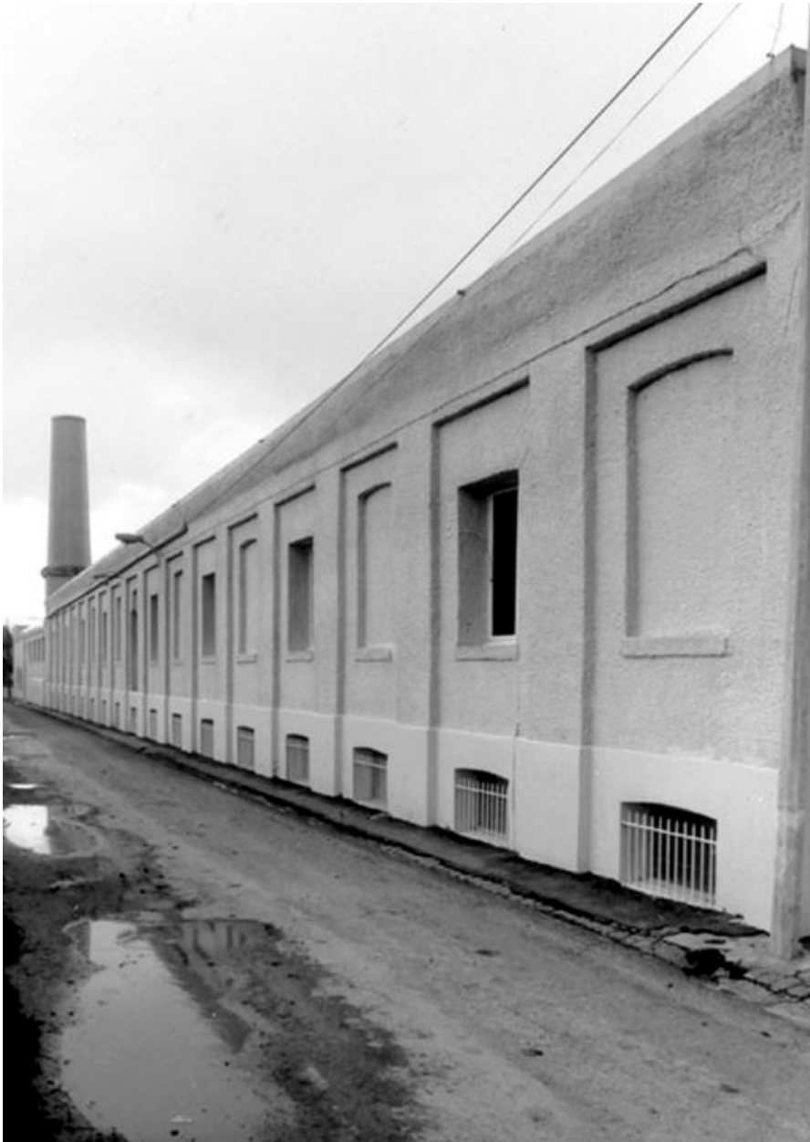
Vue partielle, élévation ouest.
