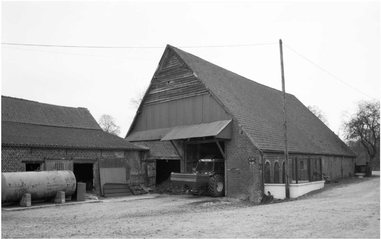
Grange : élévation sur cour.
