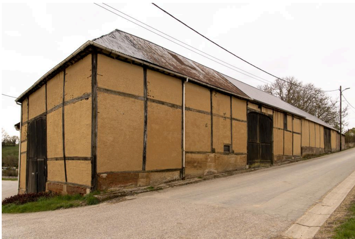
Grange de ferme, n°15 rue de Choqueuse, vue depuis le nord-est.
