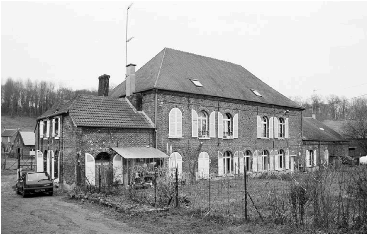
Logement patronal et bureaux : façade antérieure.
