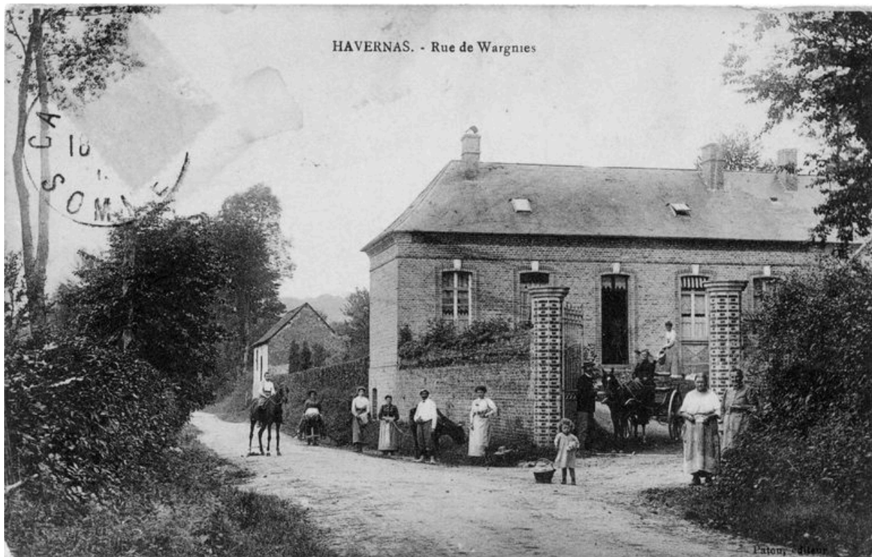
Vue partielle depuis la rue, avant 1914 (coll. part.).
