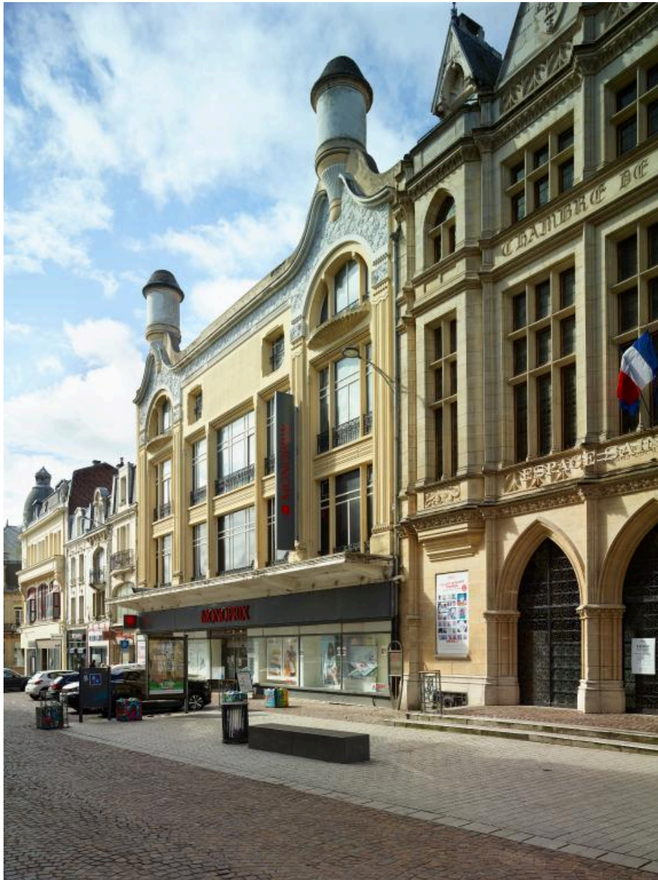
Vue de situation de la façade donnant sur la rue de la Sellerie.
