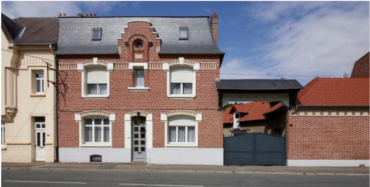
Maison de ferme, n°20 rue de Douai. Pignon associant forme arrondie et pas de moineaux.
