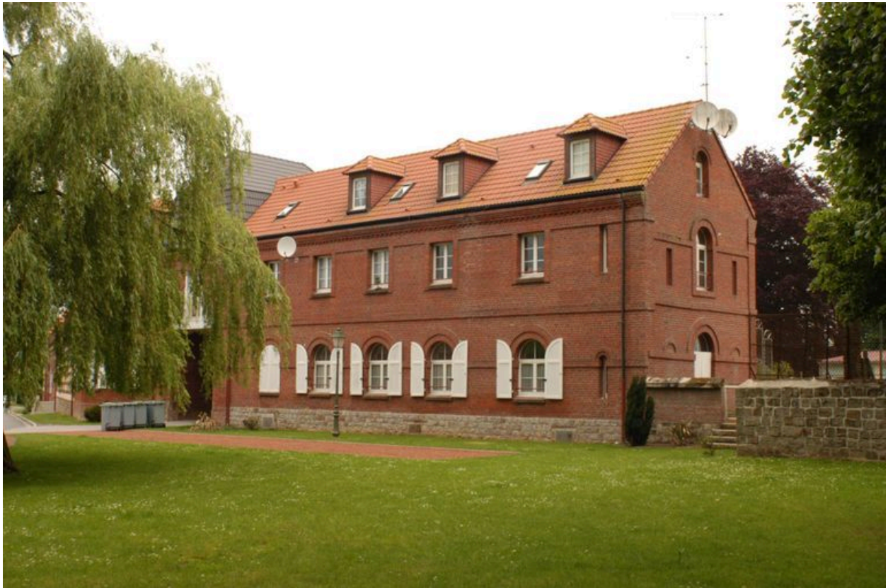
Anciennes dépendances du château : corps est, vu depuis le sud-est.
