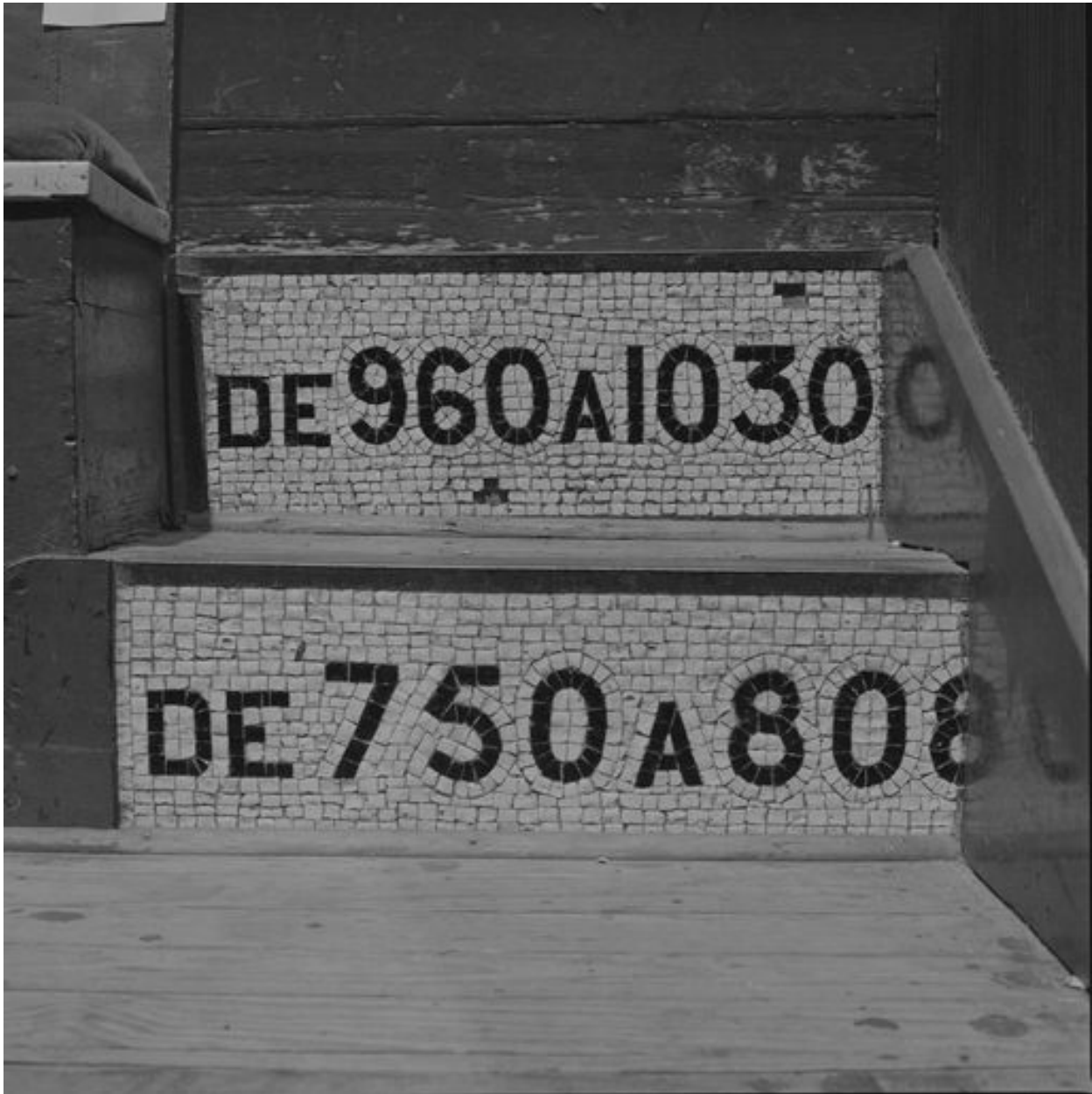
Détail des escaliers ornés de mosaïque donnant accès aux gradins.
