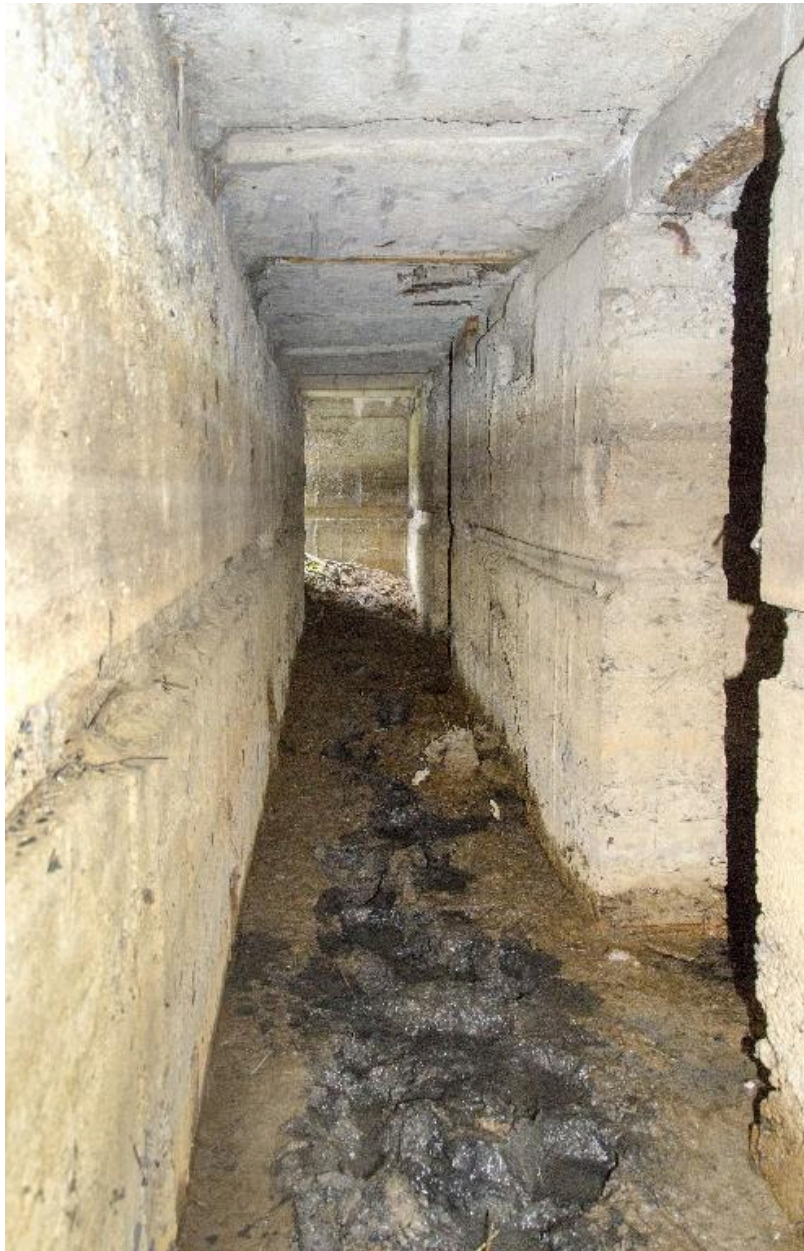
Couloir C1. Vue en enfilade vers l'ouest.
