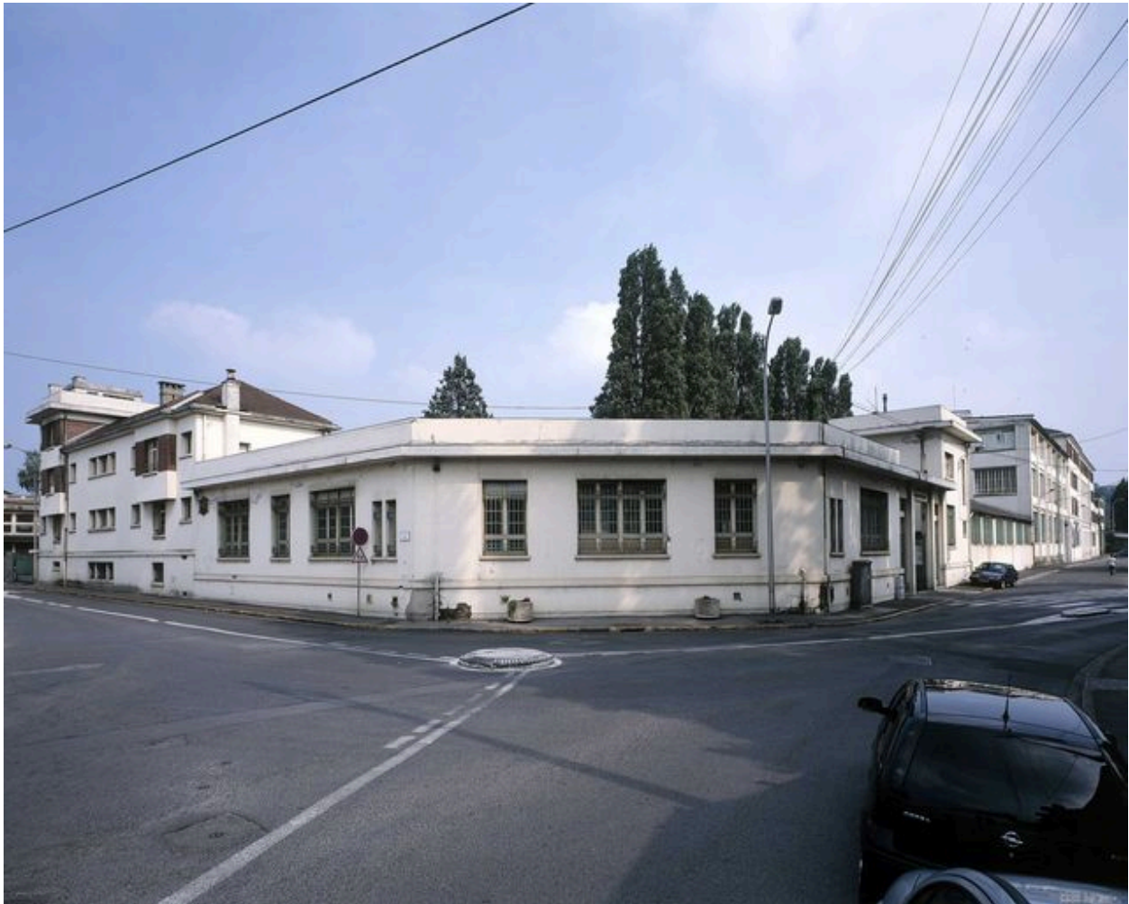
Bâtiment des bureaux formant l'angle de la rue des Usines et de la rue de Gournay.
