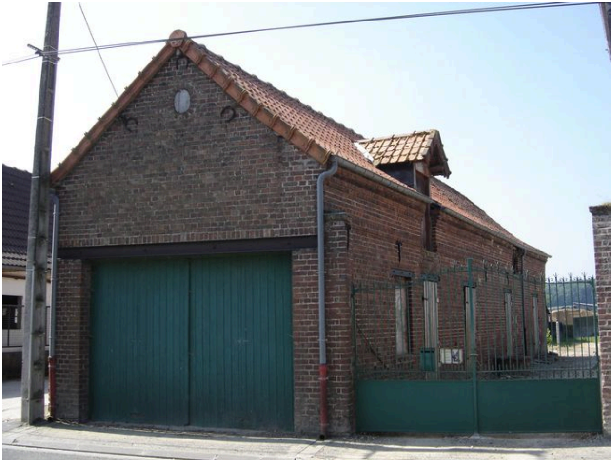
Vue des anciens bâtiments agricoles.
