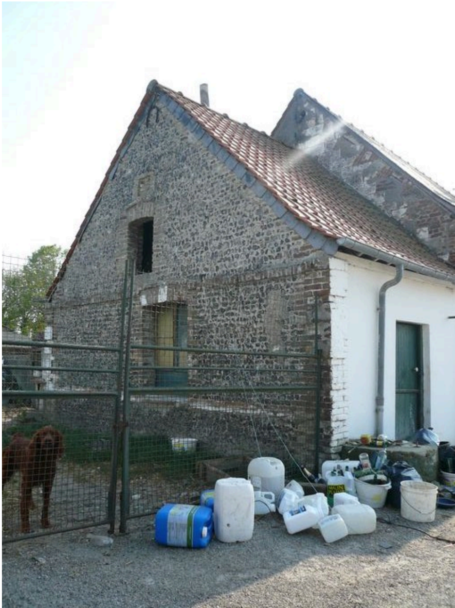
Vue détaillée du pignon de la laiterie.
