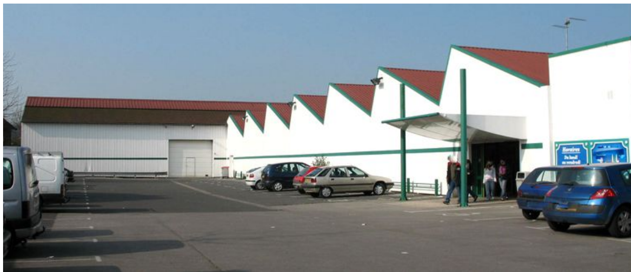
Vue générale de l'usine, façade ouest.
