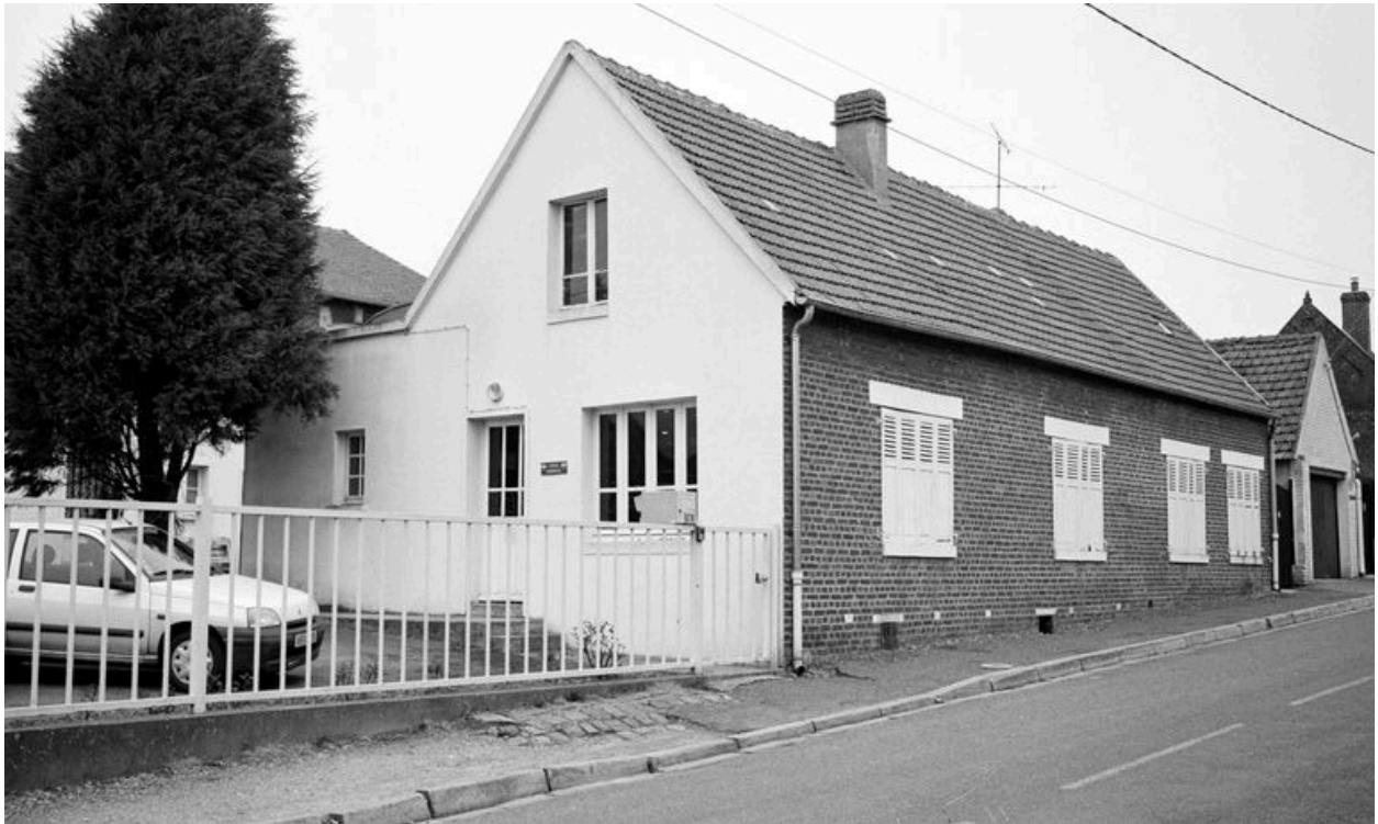
Conciergerie : façade sur rue.
