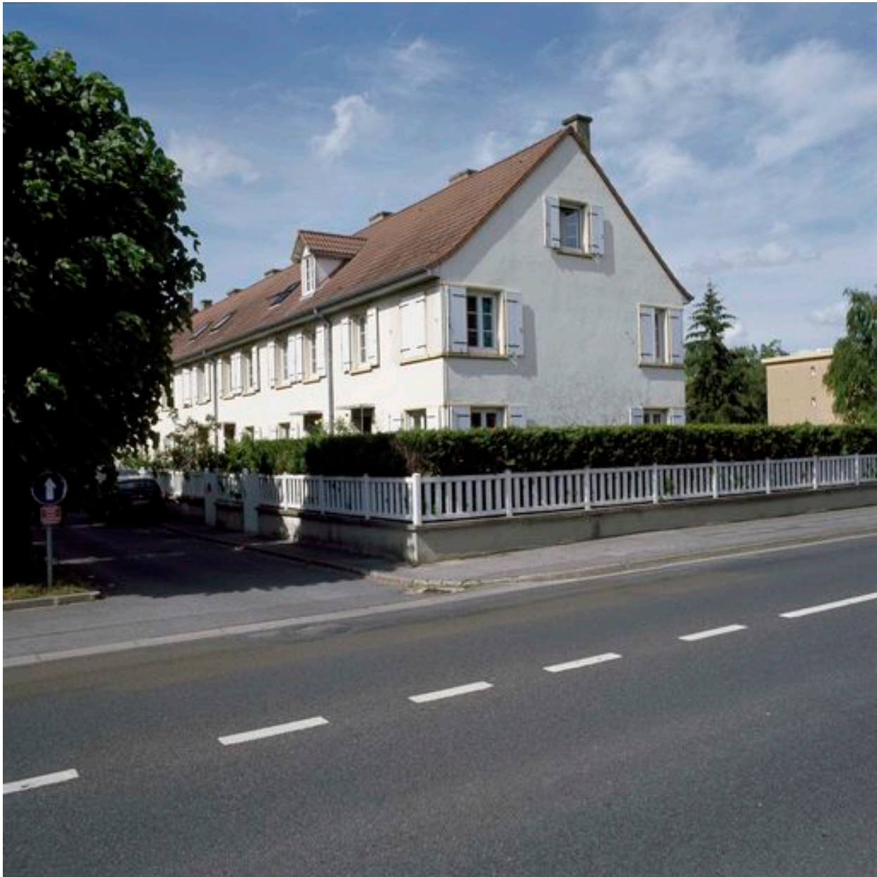
Vue d'un des immeubles à logements.
