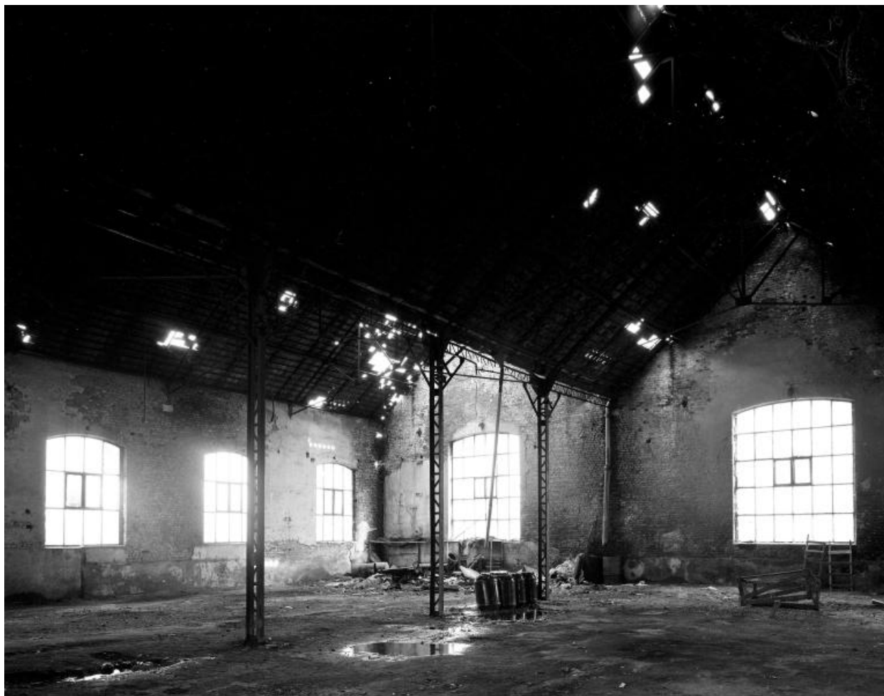
Remise ferroviaire, vue intérieure.
