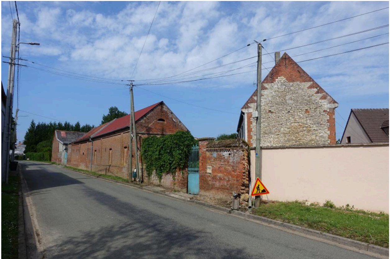
Ferme à cour, n°4 rue du Crocq, vue depuis l'est.
