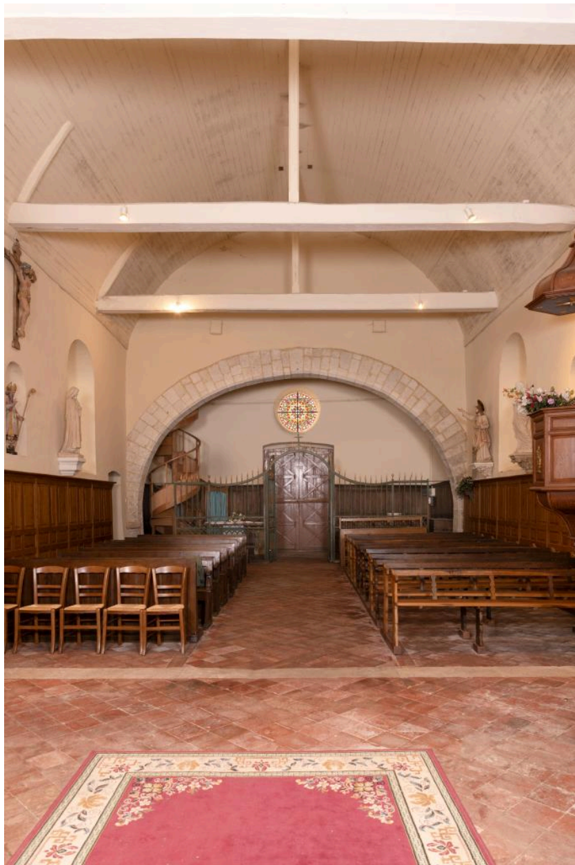
Vue intérieure vers la nef.
