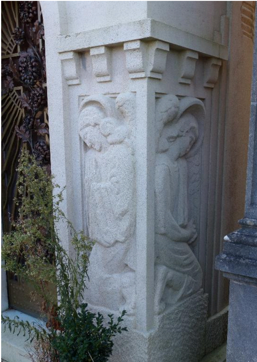
Vue de détail des sculptures (angle nord-ouest)
