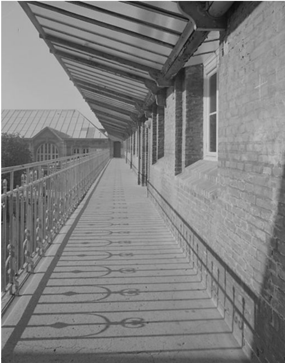
Coursière de distribution de l'étage.
