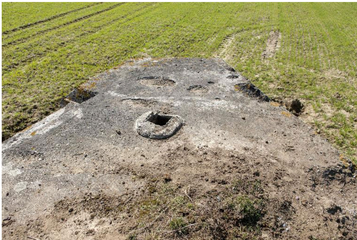
Couvrement, cheminée du périscopes
