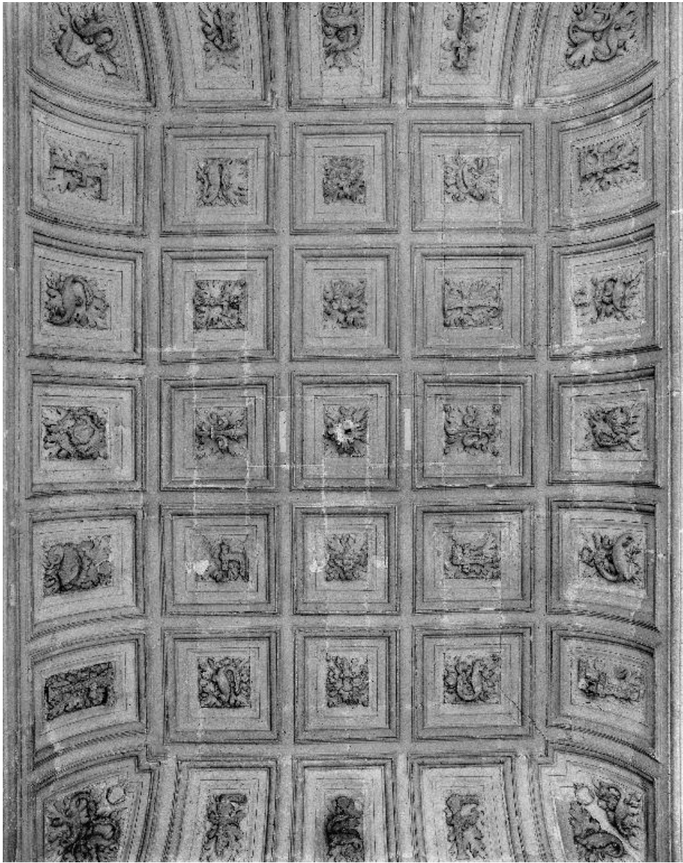
Vue générale de la voûte.
