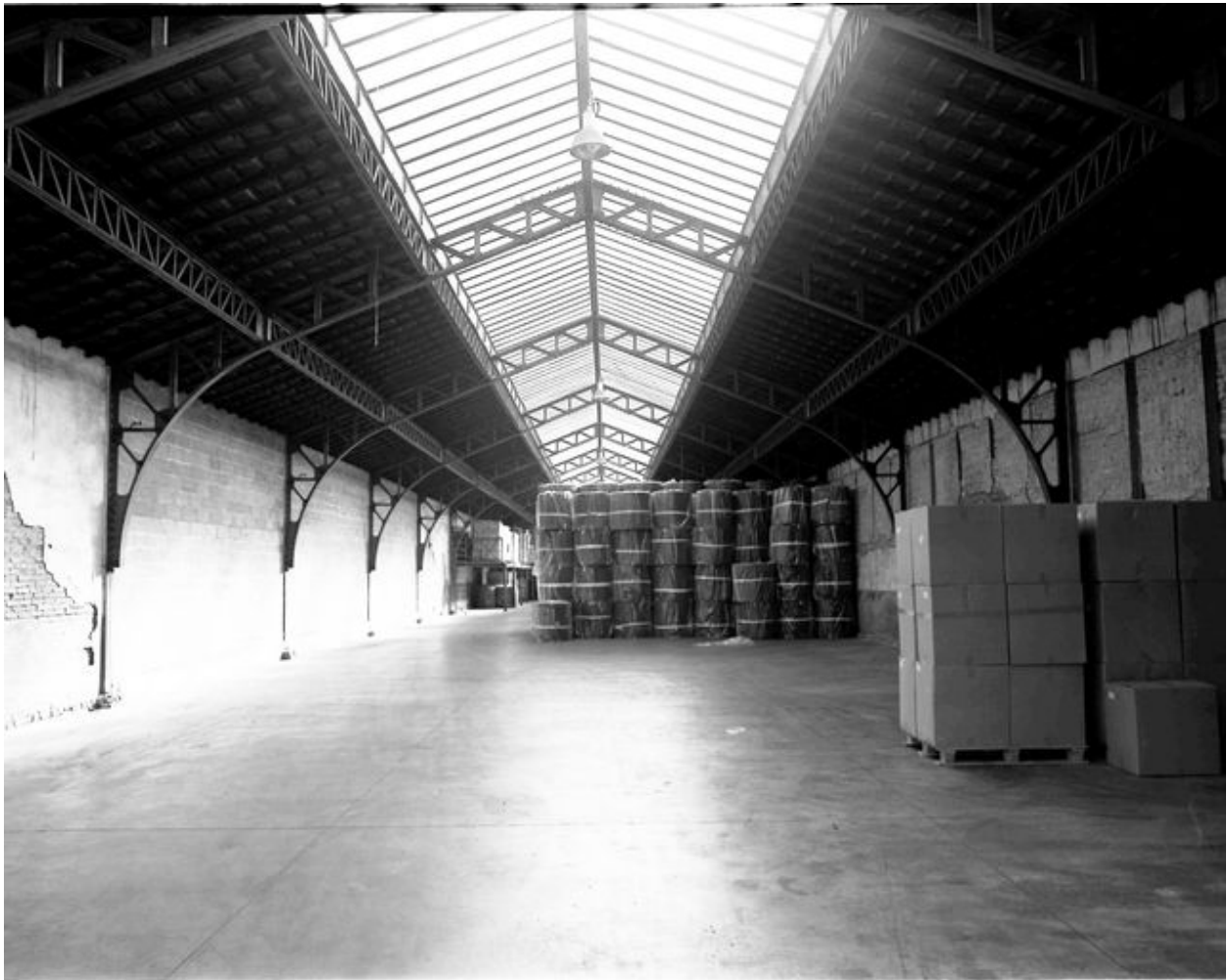
Intérieur du magasin industriel.
