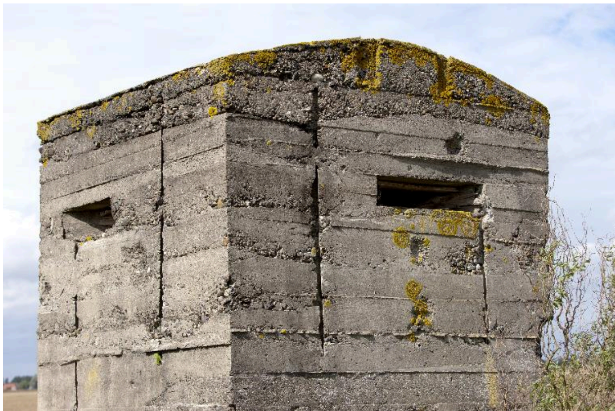
Ebrasures sud-est (vers Aubers) et sud-ouest (vers le front)
