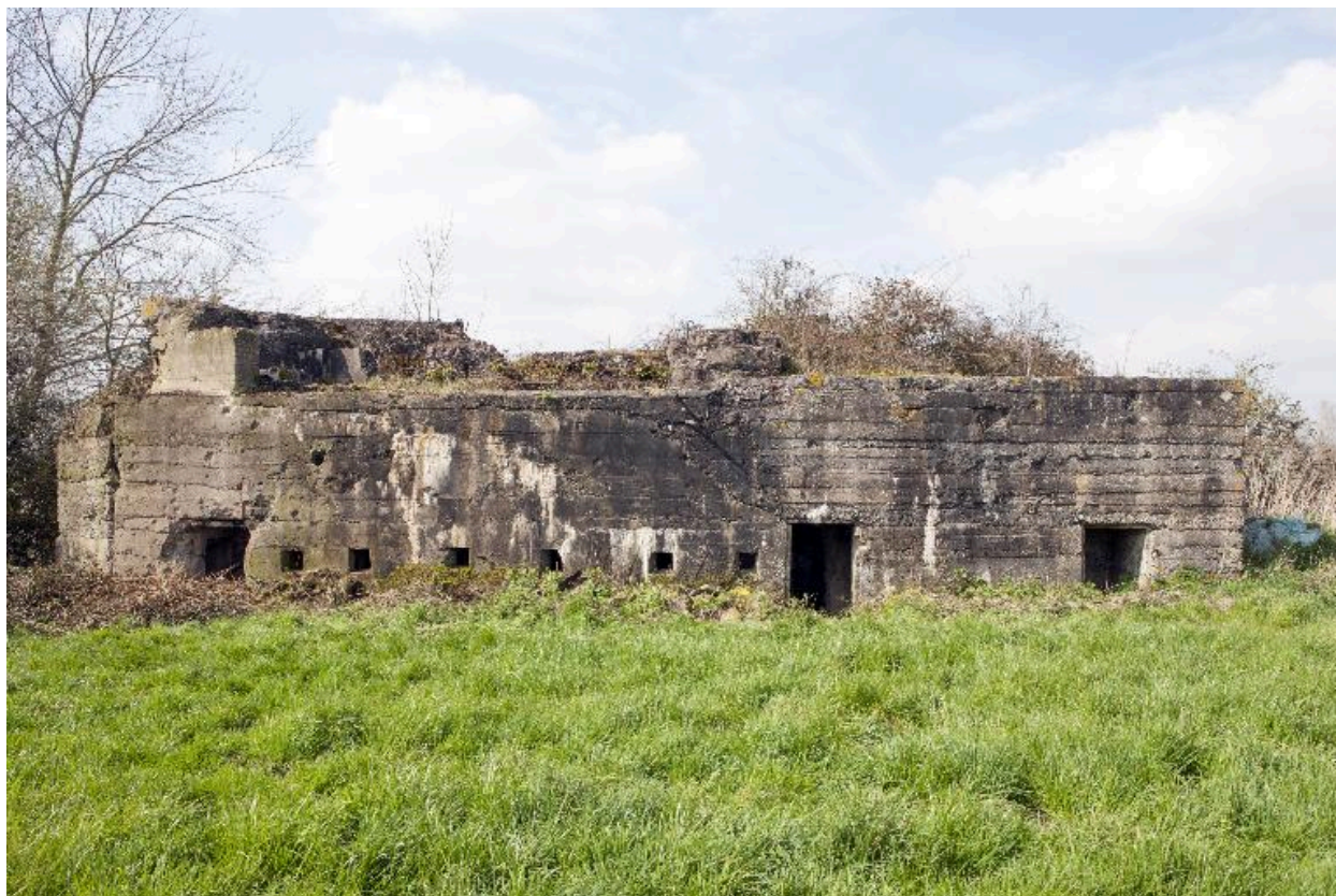
Casemate A : Vers le nord ouest
