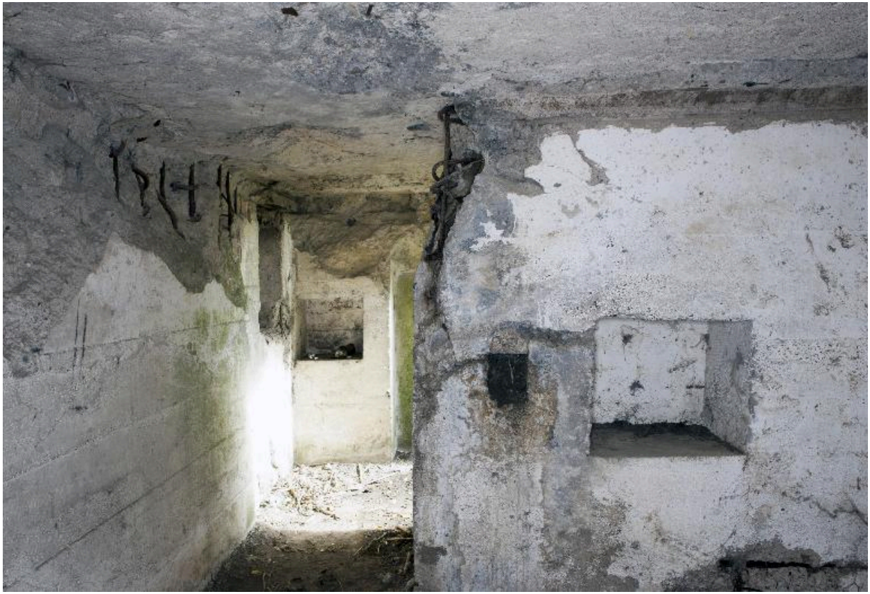
Couloir en chicane de l'entrée est, vers l'extérieur.
