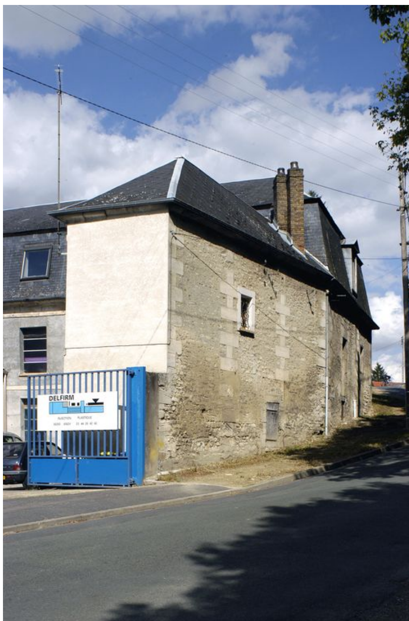
Vue de l'entrée de l'usine et de la façade sur rue de l'usine.
