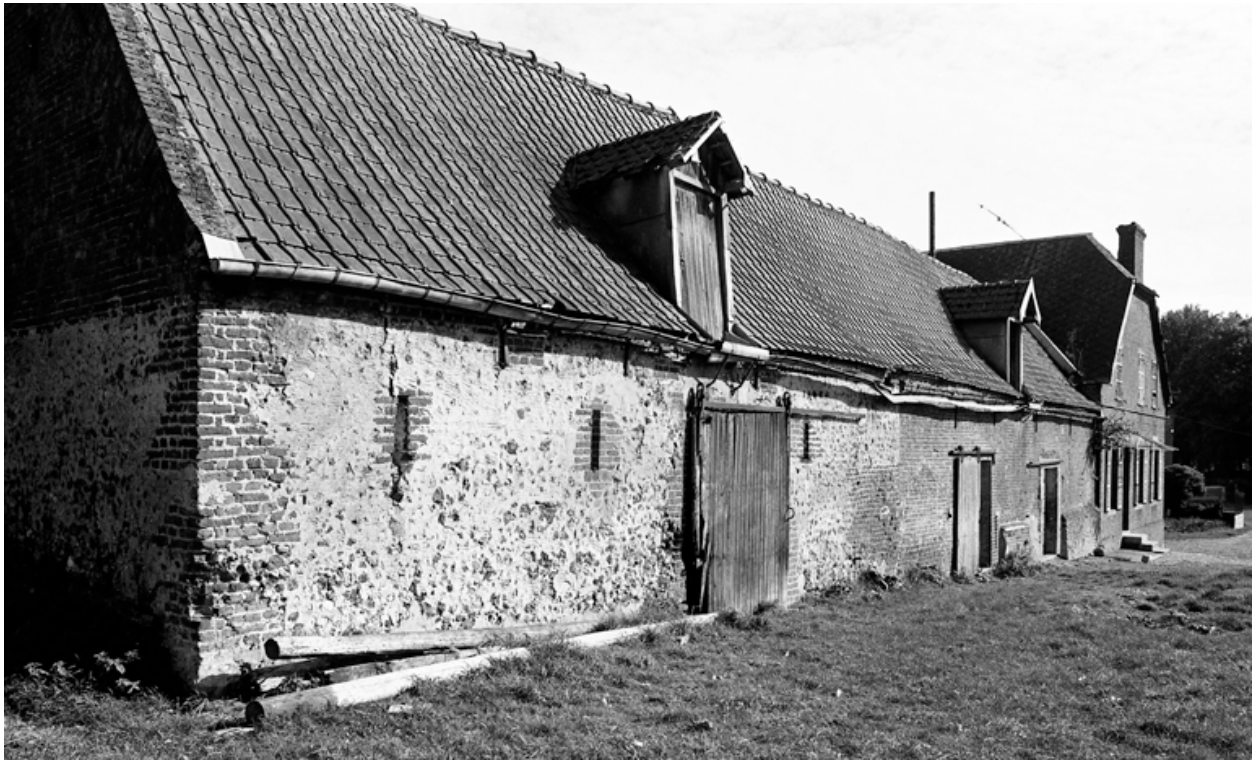
Première ferme : vue d'ensemble des étables depuis l'ouest.
